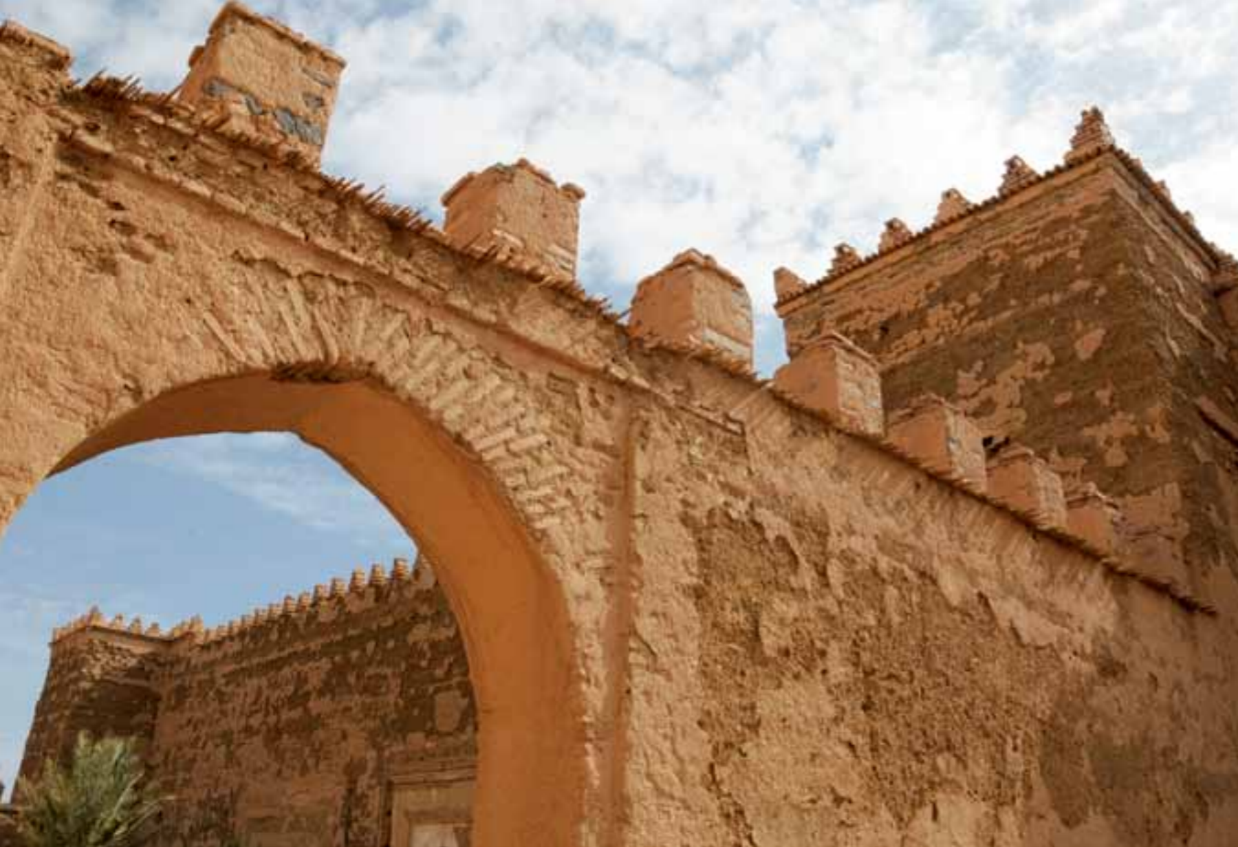
Entrée du deuxième pavillon à la Prison d'Agdz
