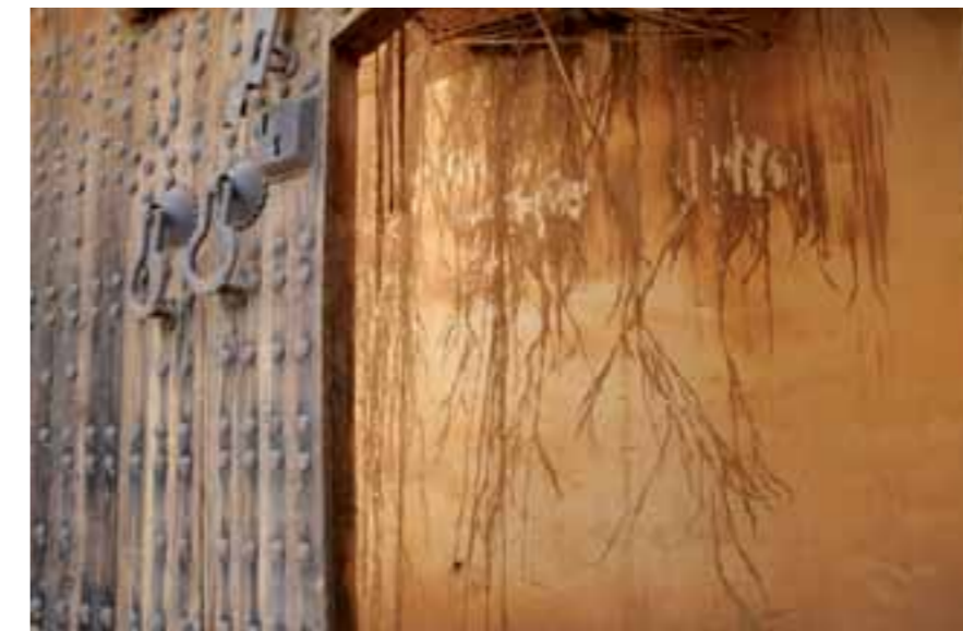
Porte extérieure des cellules au deuxième pavillon de la même Prison
