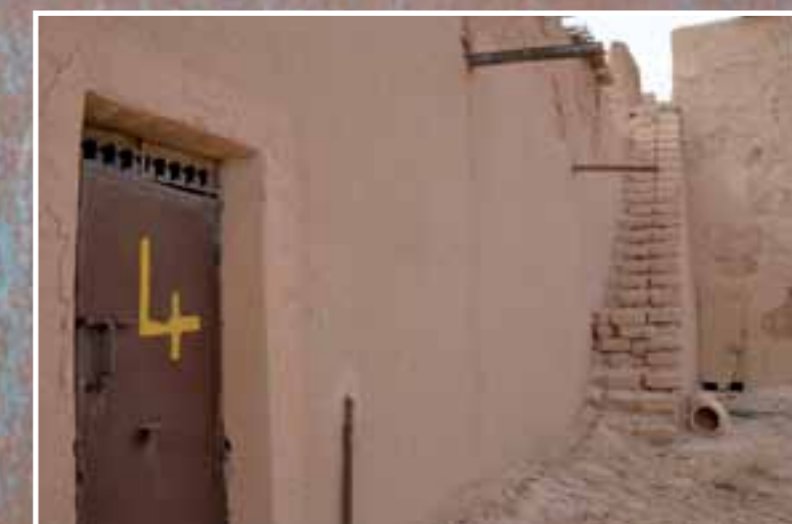
Escalier pour gardes
